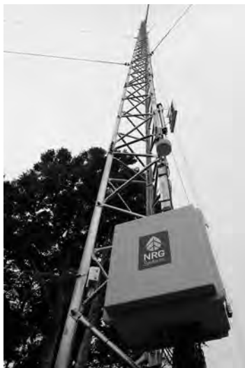
工事の一部は既に進められている。 風力観測用鉄塔（H ≒ 50m）
